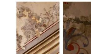
Fisuras y microfisuras que se producen por el movimiento de la estructura de madera (alfajías)
